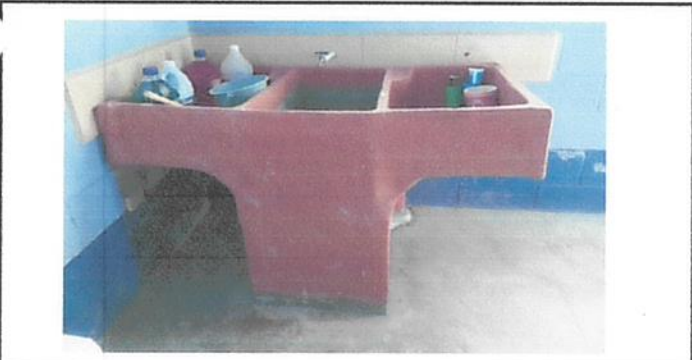
Foto 5: Instalación de pila
