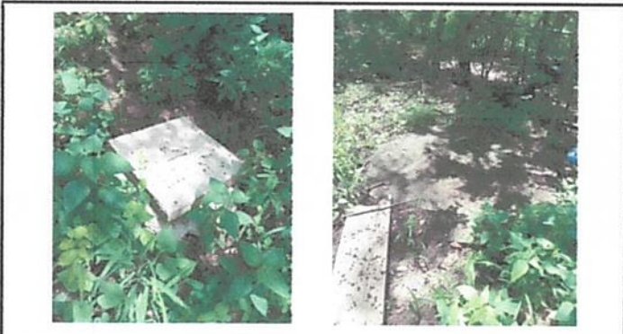
Foto 3: Instalacion de fosa septica
