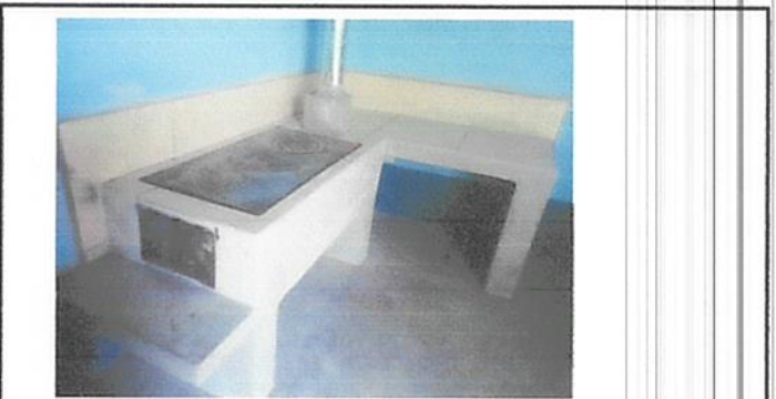
Foto 6: Estufa rural, con instalacion de plancha y chimenea
